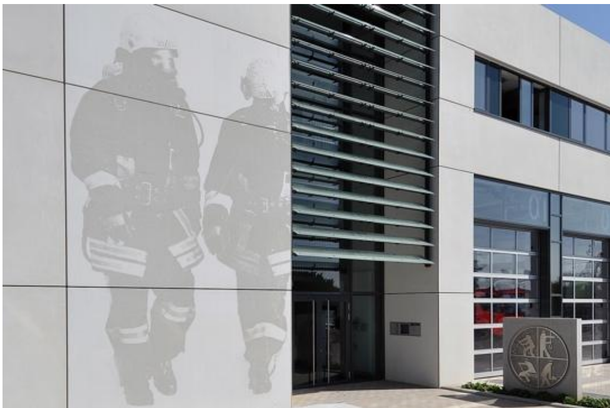
Rys. 12. Budynek straży pożarnej, Langenfeld, Niemcy.
