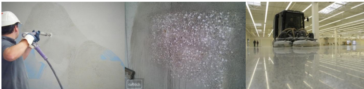
Rys. 6. Od lewej: impregnacja (przemywanie wodą), piaskowanie, polerowanie.
