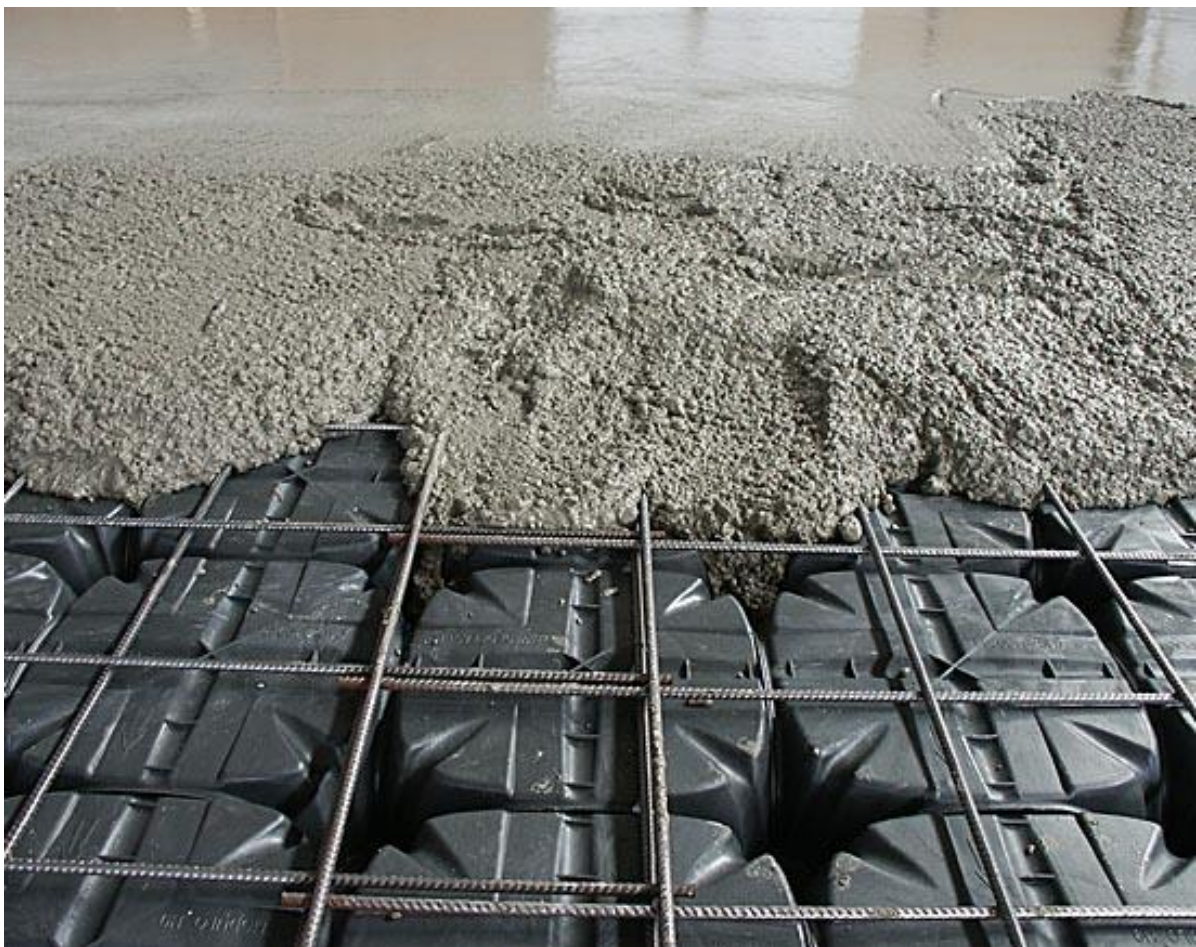
Rys. 14 i 15 Zalewanie deskowania Modulo mieszanką betonową.
