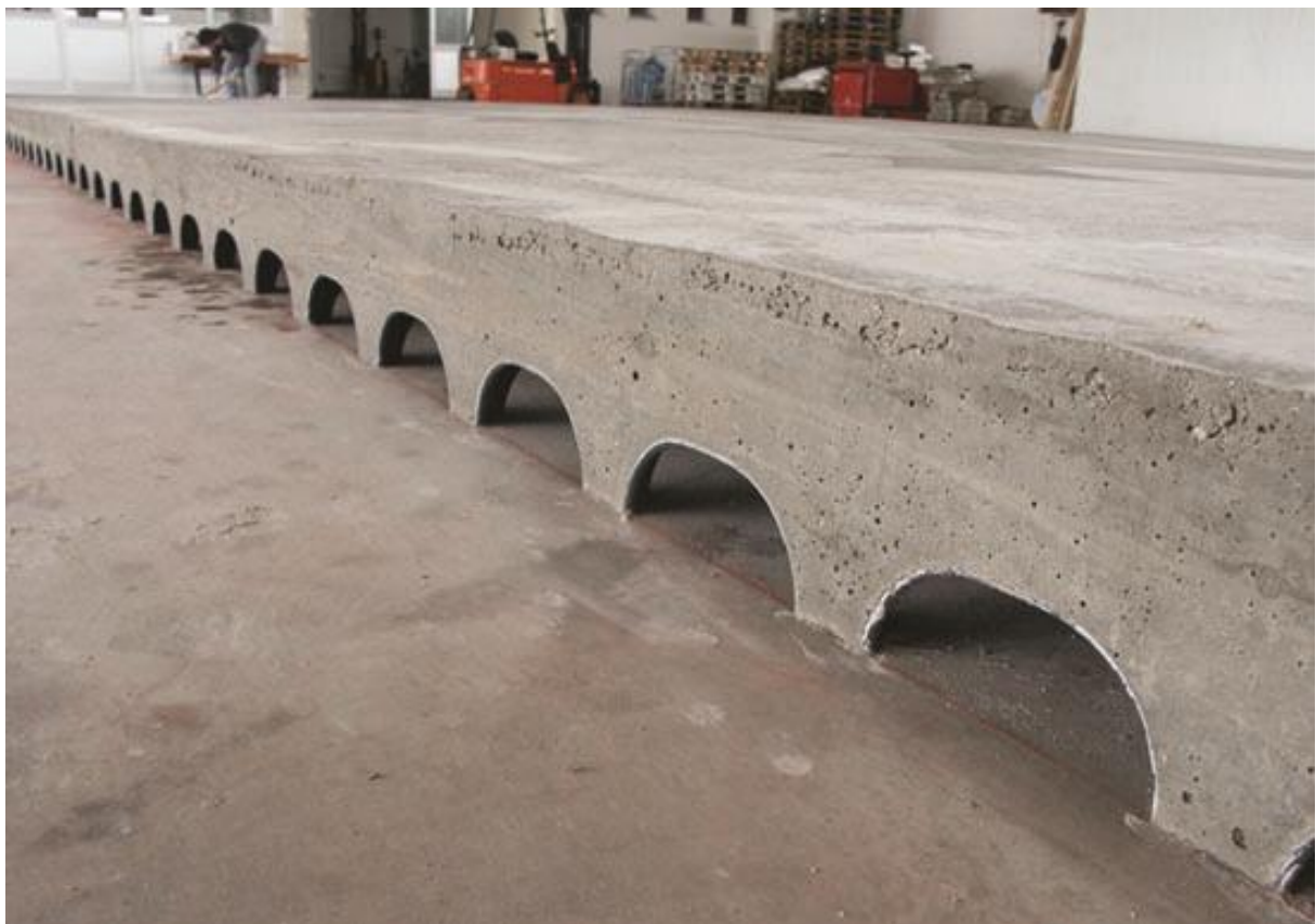
Rys. 16 i 17 Przykład wykonanych płyt fundamentowych przy użyciu Modulo
