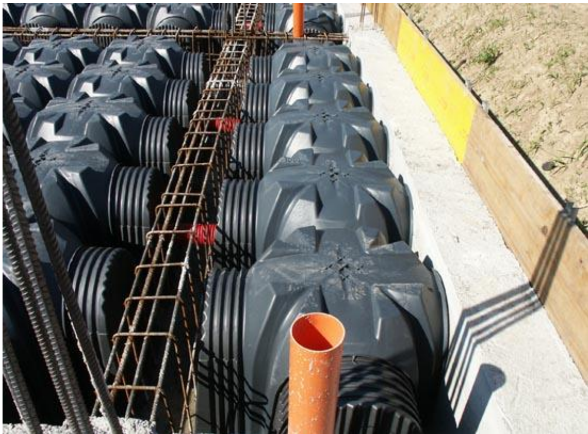
Rys. 12 i 13. Układ belek zbrojeniowych i systemu rur wentylacyjnych pomiędzy deskowaniem Modulo.
