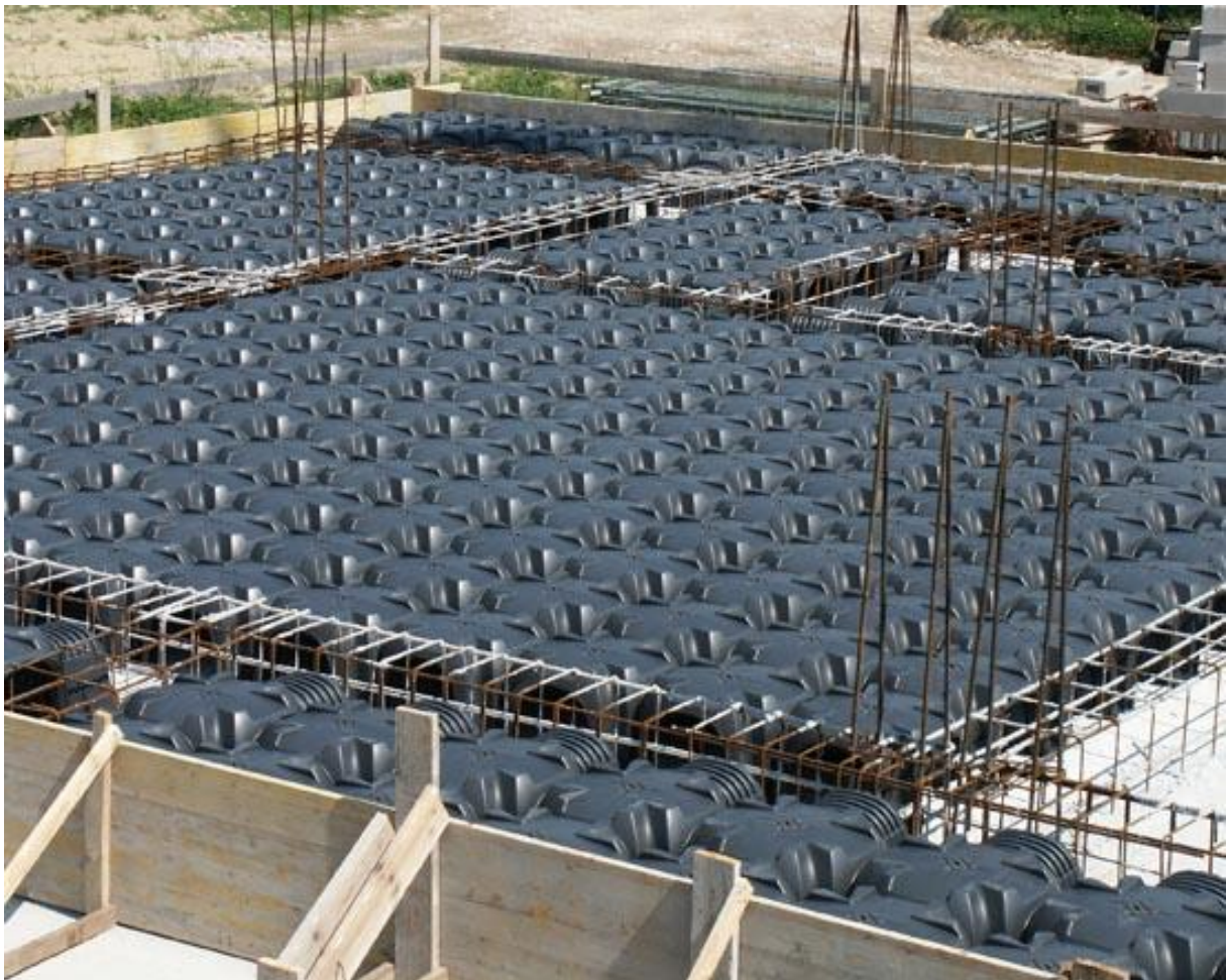
Rys. 10 i 11. Przykład ułożonego Modulo przed betonowaniem.
