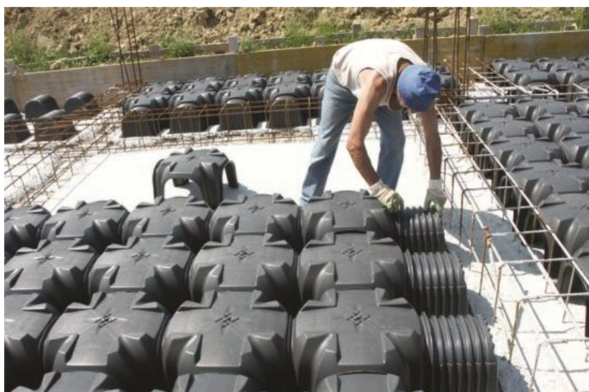
Rys 8. i 9. Układanie Modulo na płycie z chudego betonu.
