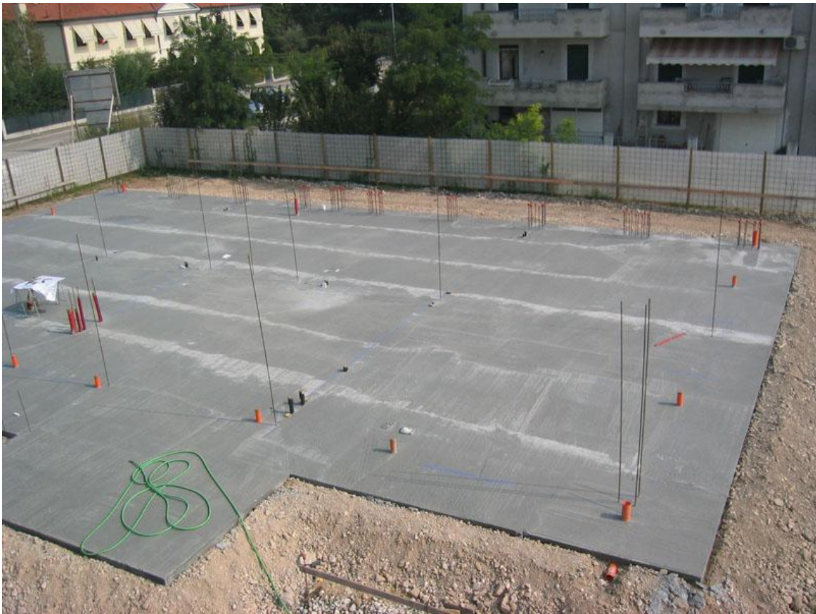
Rys. 18 i 19 Modulo przed i po robotach betoniarskich.
